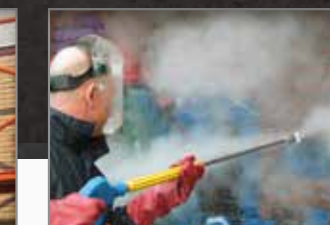
Grafiidi eemaldamine: ilma puhastusvahendite/ eemaldajata
